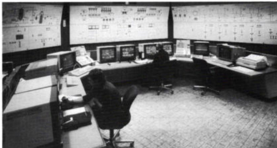
Meetswacht van Hoogoven 6 met het TELEPERM M automatiseringssysteem.
